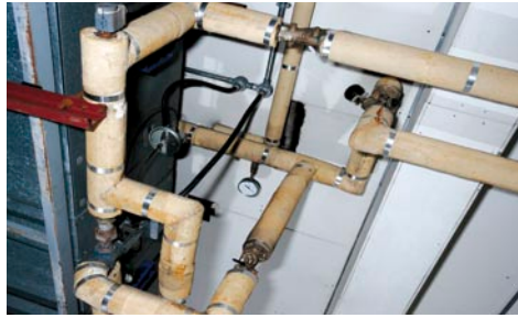
Asbestos pipe lagging
